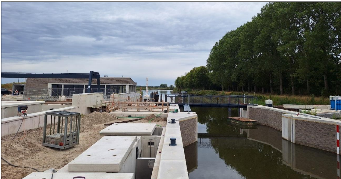
Beeld richting het Lauwersmeer met gemaal Hunsingo en de nieuwe sluis
